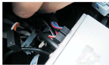
31 将AV线束及屏连接线 with 主机连接,整理好主机后端线束将主机放好
